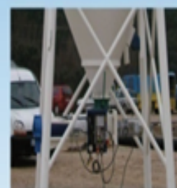
ABASTECIMIENTO DEL MORTERO SECO EN OBRA, CON SISTEMA NEUMÁTICO Distribution with pneumatic conveying
